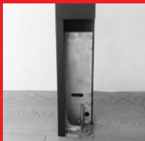
Erős, rejtett rögzítés az oszlop és a terasz-padló csatlakozásánál.
